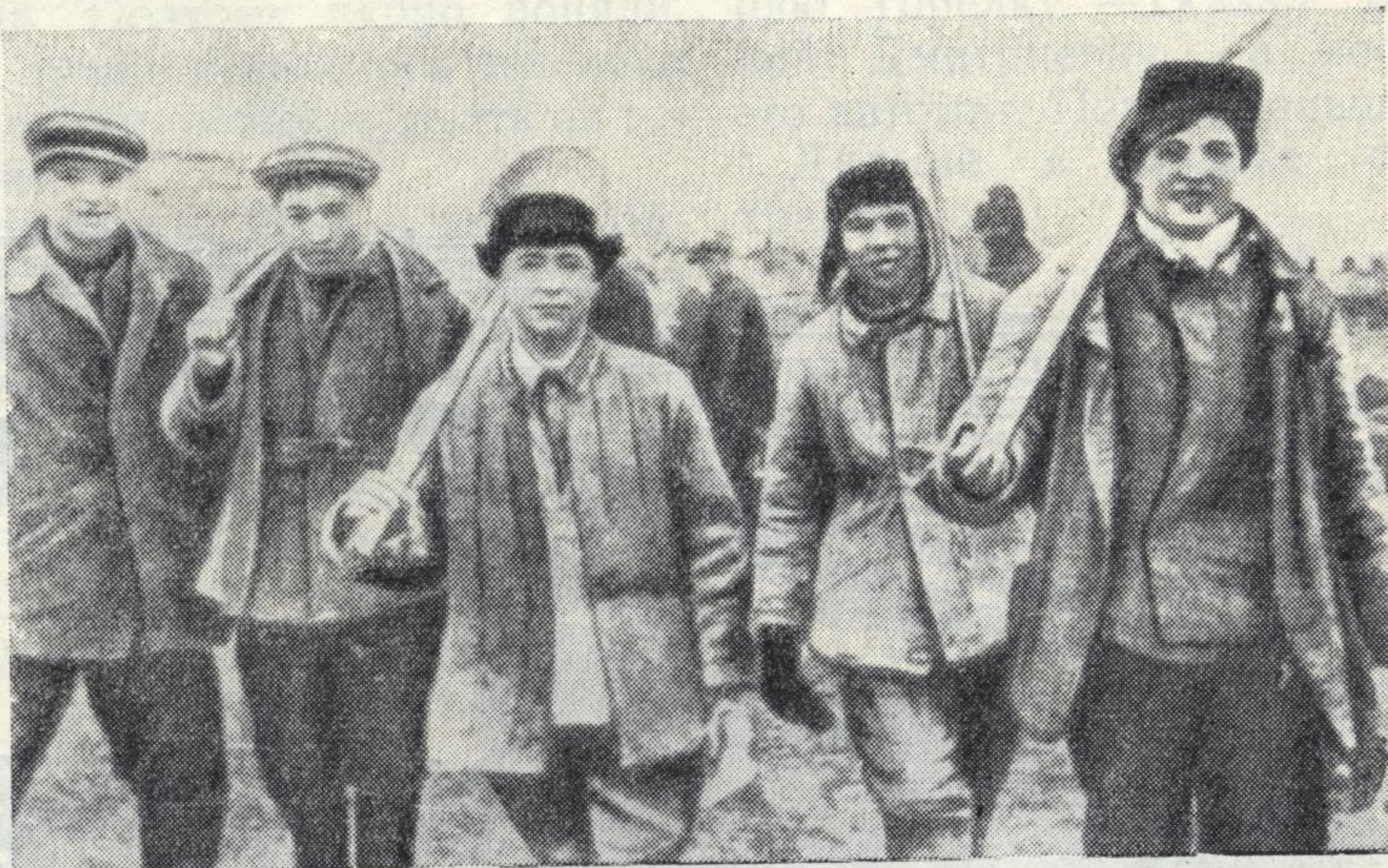
Ударная комсомольская бригада бетонщиков на строительстве Днепрогэса
